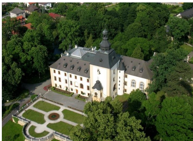
Pałac w Kamieniu Śl. po odbudowie. Fot. Archiwum Sanktuarium św. Jacka.
